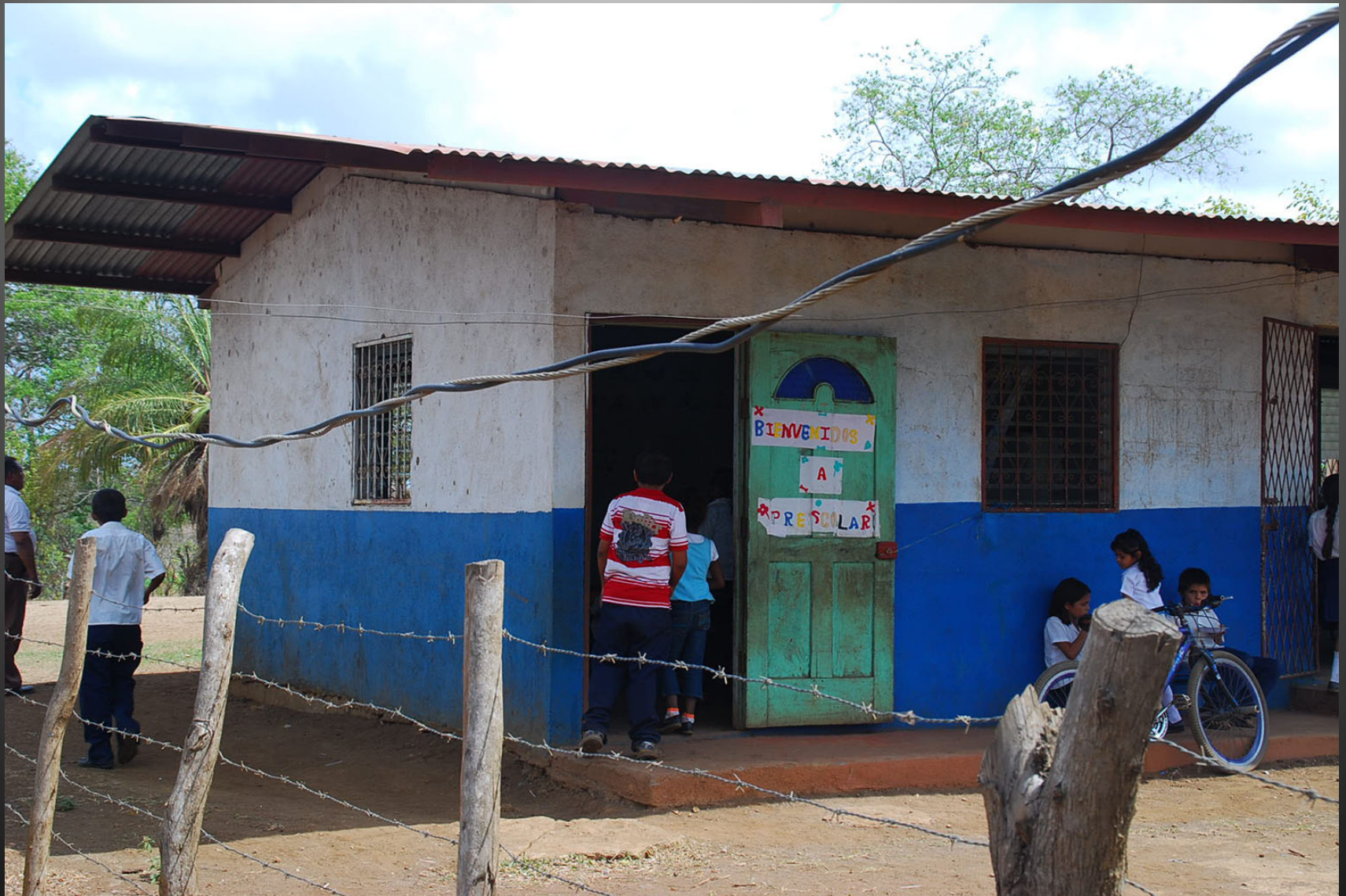
Escuela preescolar (construido por AMSOGRA en 2008 en Santa Amalia)
